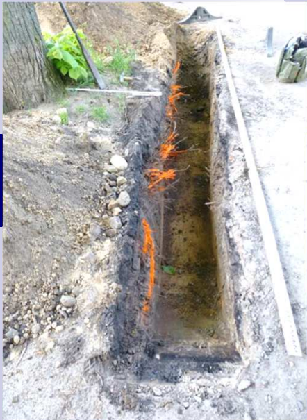
Suchschachtung im Bereich Fahrbahnrand
