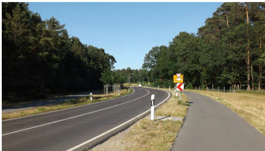
Abbildung 13: Potsdamer Damm (links: Waldgebiet Parforceheide, rechts: Grundstück Potsdamer Damm 1).
