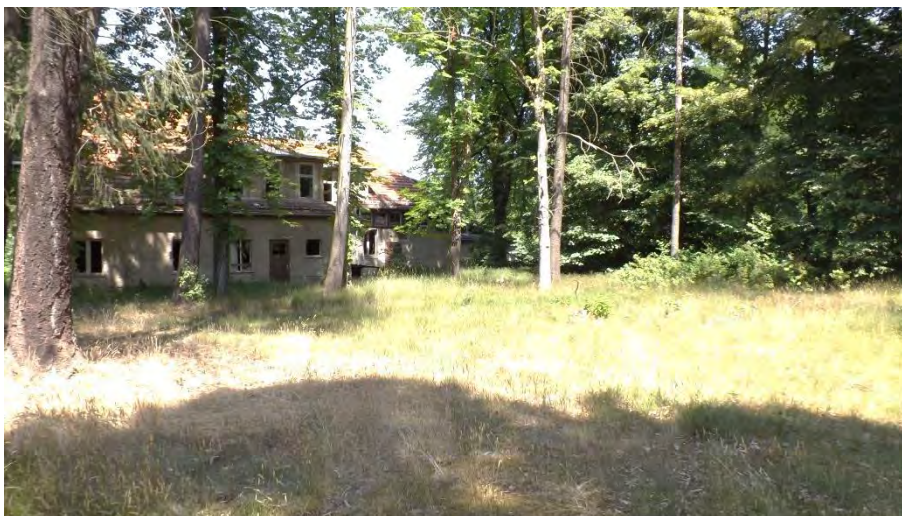
Abbildung 16: Das leerstehende Wirtschaftsgebäude, Blick von SW.
