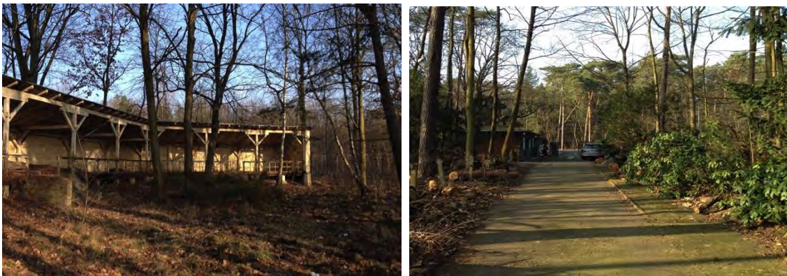
Abbildung 5: Liegehalle, Grundstückszufahrt, April 2018
