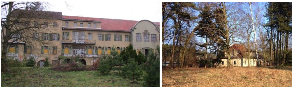
Abbildung 4: Hauptgebäude, ehem. Wirtschaftsgebäude, April 2018
